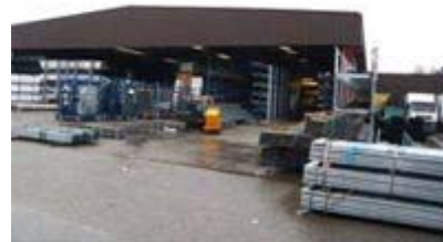
Bâtiment de 3 170 m 2 de type industriel à Cerisé
