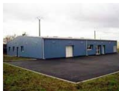
Bâtiment de 420 m 2 de type industriel à Athis de l'Orne
