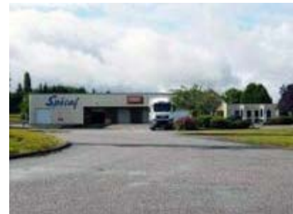
Bâtiment de 450 m 2 à Lonrai
