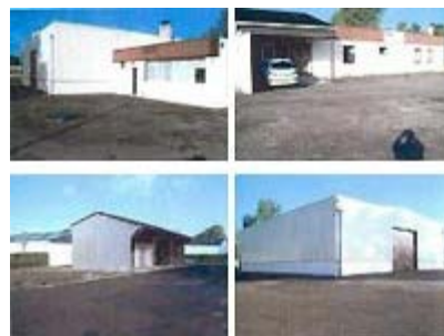
Bâtiment de 800 m 2 à La Ferté Macé
