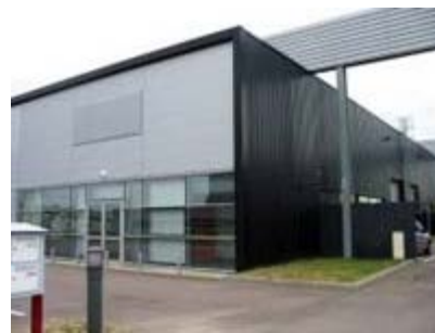
Bâtiment de 400 m 2 à L'Aigle
