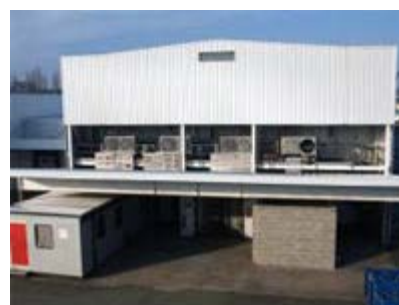
Ensemble de 4 bâtiments sur 2961 m 2 à Alençon
