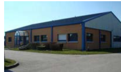
Bâtiment de 575 m 2 à Marmouillé
