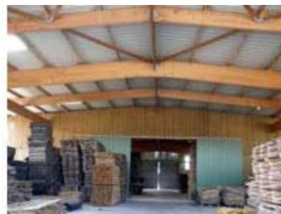
Bâtiment de 1400 m 2 à Condé-sur-Sarthe
